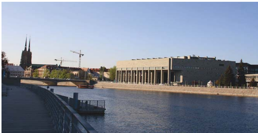
Alte und neue Bausubstanz dicht nebeneinander.
