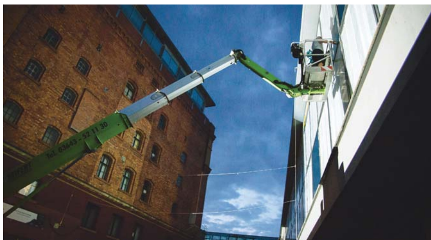
Die Fassadenfenster am Neubau der Bibliothek der Bauhaus-Universität werden für die Fassadenprojektionen abgeklebt. Foto Henry Sowinski
