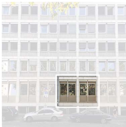
Bestandsfassade Hasengasse | Ausschnitt
