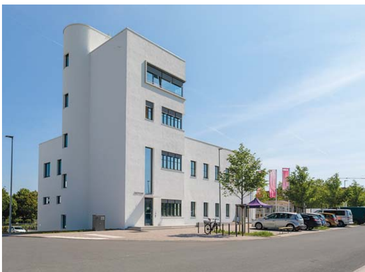
Die neue Quartiersbibliothek Hubland ist im Tower eines ehemaligen Militär-Flugplatzes untergebracht und nutzt dort zwei Etagen. Foto: Marco Heyda
