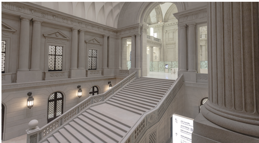
Die Haupttreppe führt vom Erdgeschoss ins Vestibül, über der Haupttreppe wurde das einstige Tonnengewölbe wieder freigelegt und baulich nachempfunden.
