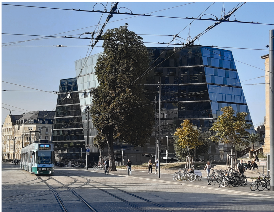
Universitätsbibliotheken, hier die UB Freiburg, werden immer mehr zu Lern- und Wissensorten. Diese benötigen unterschiedliche Raumangebote, von der kleinen Arbeitszelle bis zum Gruppenarbeitsraum.
