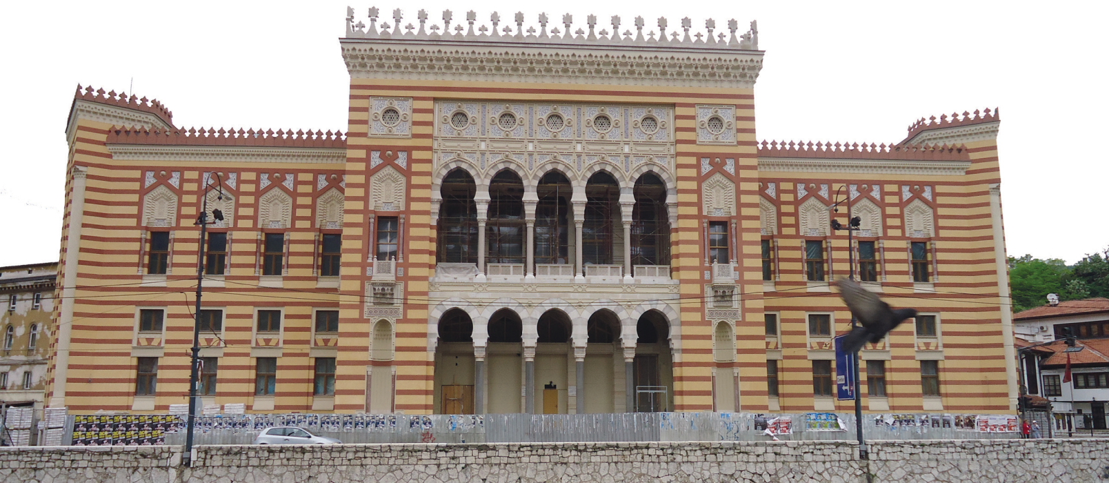
Während der Belagerung von Sarajewo im Bosnienkrieg wurde auch die Nationalbibliothek von Bosnien und Herzegowina schwer beschädigt. Mittlerweile wurde das Gebäude saniert und die Kriegsschäden behoben. Schwester Maria hat die Kriegswirren in dem Land miterlebt.
