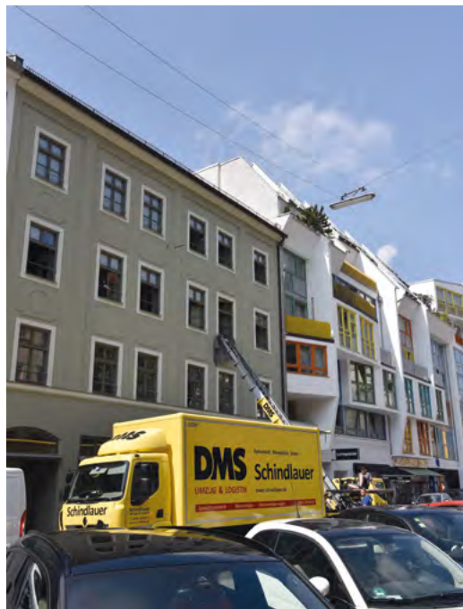
Für den Transport der Bücher der Bibliothek des Instituts für Nordische Philologie war eine partielle Straßensperrung nötig, um mit einem Außenaufzug arbeiten zu können.
